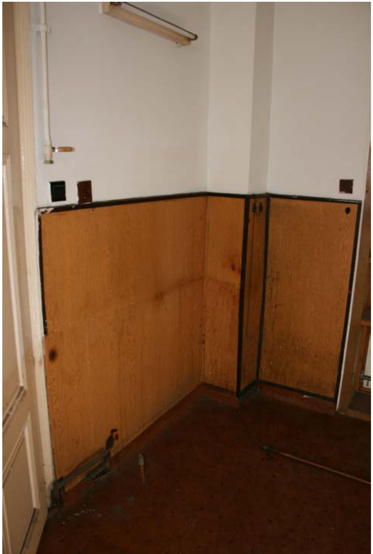
5 Przed remontem - kuchnia
