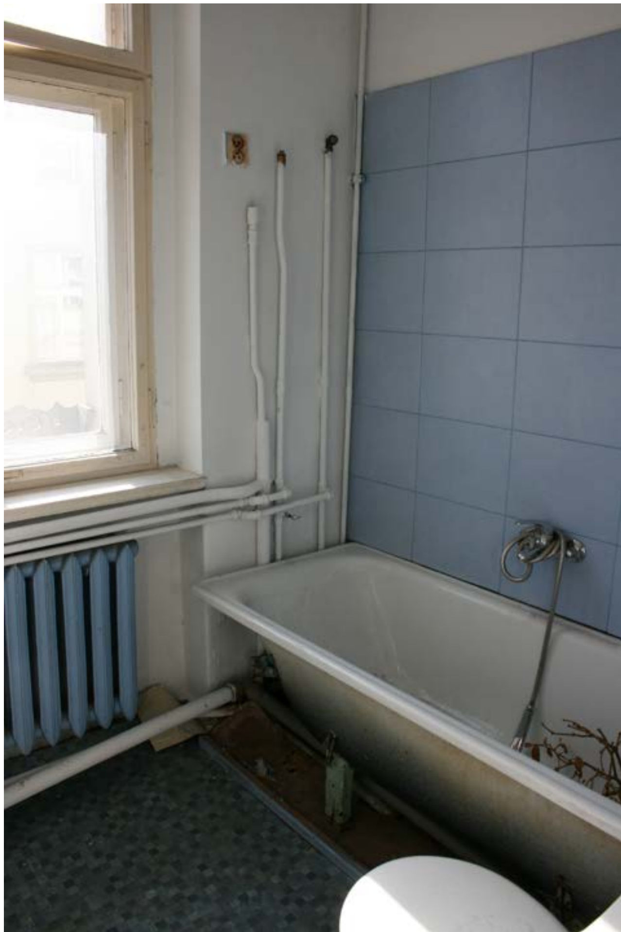
6 Przed remontem - łazienka
